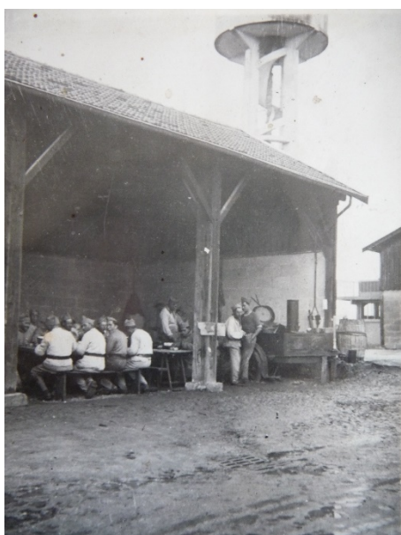
Grand hangar à charrettes servant d'abri au « cantonnement d'une batterie de DCA » (1937)
